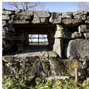
Et rør stikker opp av bakken på innsiden av muren.
